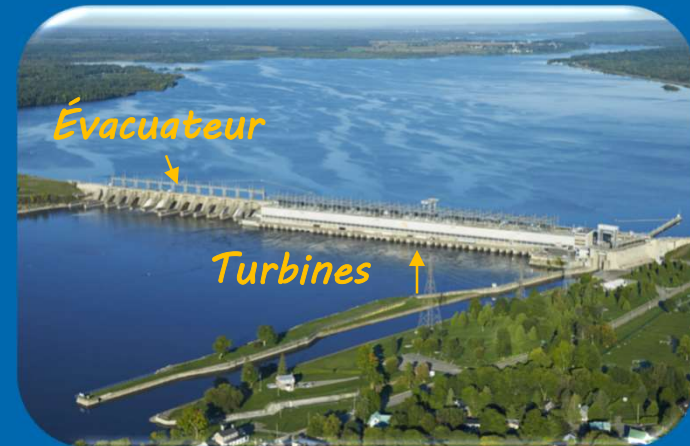
Centrale au fil de l'eau
