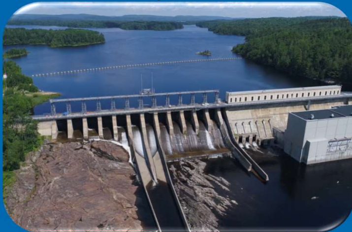
À réservoir (avec ou sans centrales)
