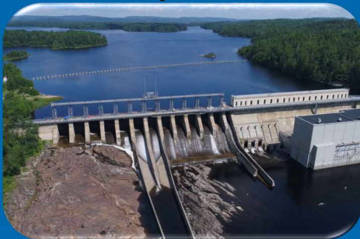
À réservoir (avec ou sans centrales)
