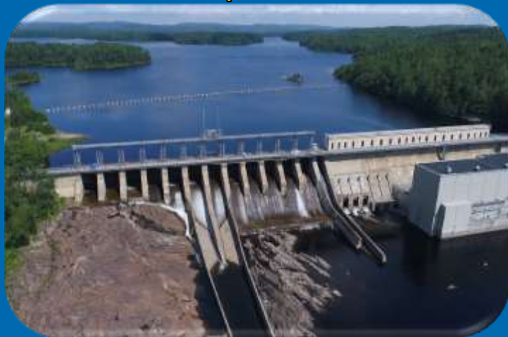
À réservoir (avec ou sans centrales)
